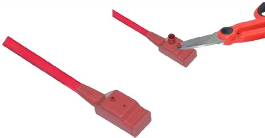
11: Cuando la silicona esté endurecida, corte los embudos de llenado y desgasificación.
