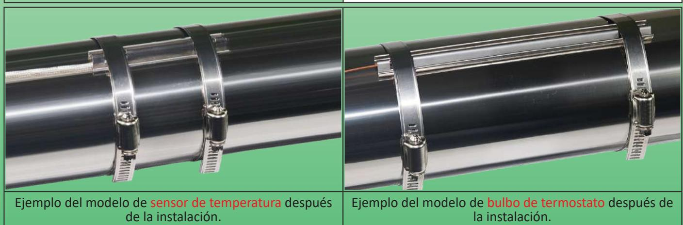
Ejemplo del modelo de **sensor de temperatura** después de la instalación.
